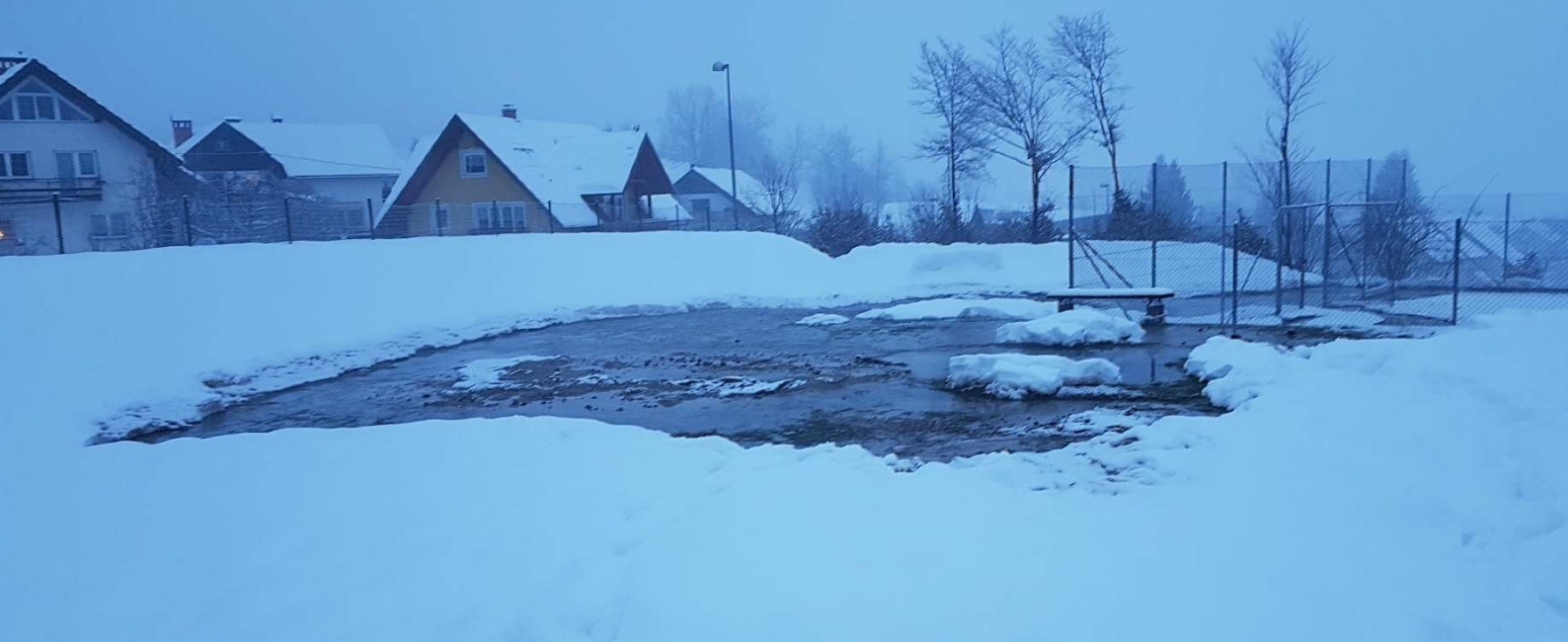
Napaka na javnem vodovodu pri Emausu v Zgornjih Gorjah
